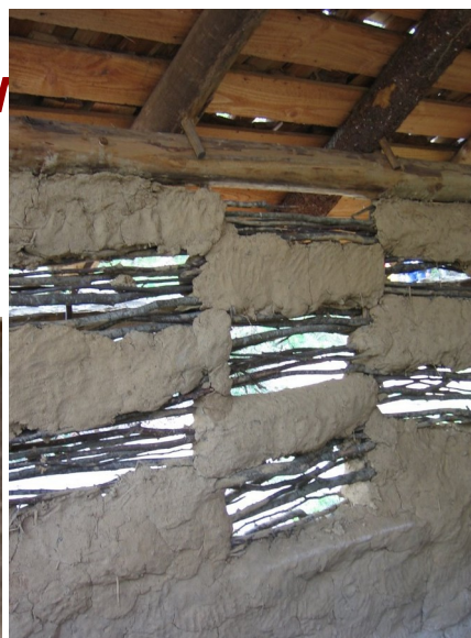
Mur en torchis au chantier Médiéval du Guédelon (Yonne)
