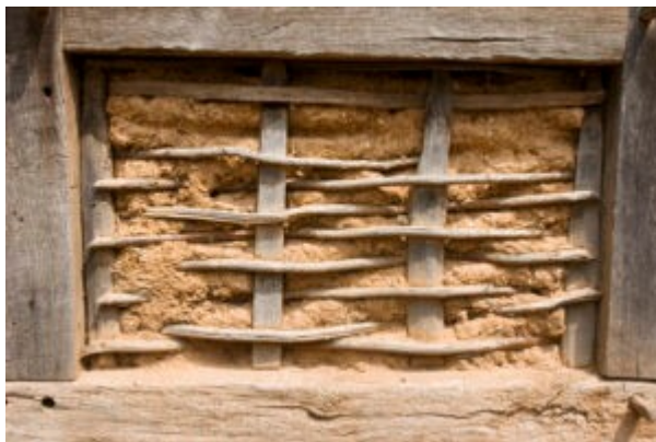
Mur en torchis au chantier Médiéval du Guédelon (Yonne)
